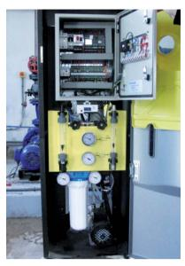
Vista anterior sistema nanofiltración: abajo post-filtro y bomba; arriba, cuadro de control
